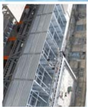
Монтаж бункера или транспортера
