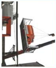
Монтаж смесительного бункера
