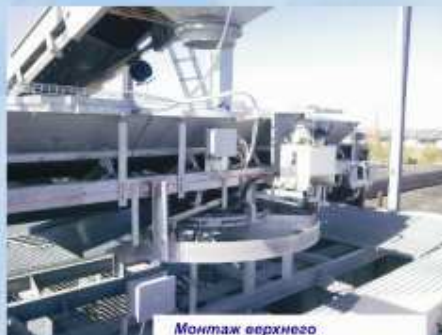
Монтаж верхнего поворотного транспортера
